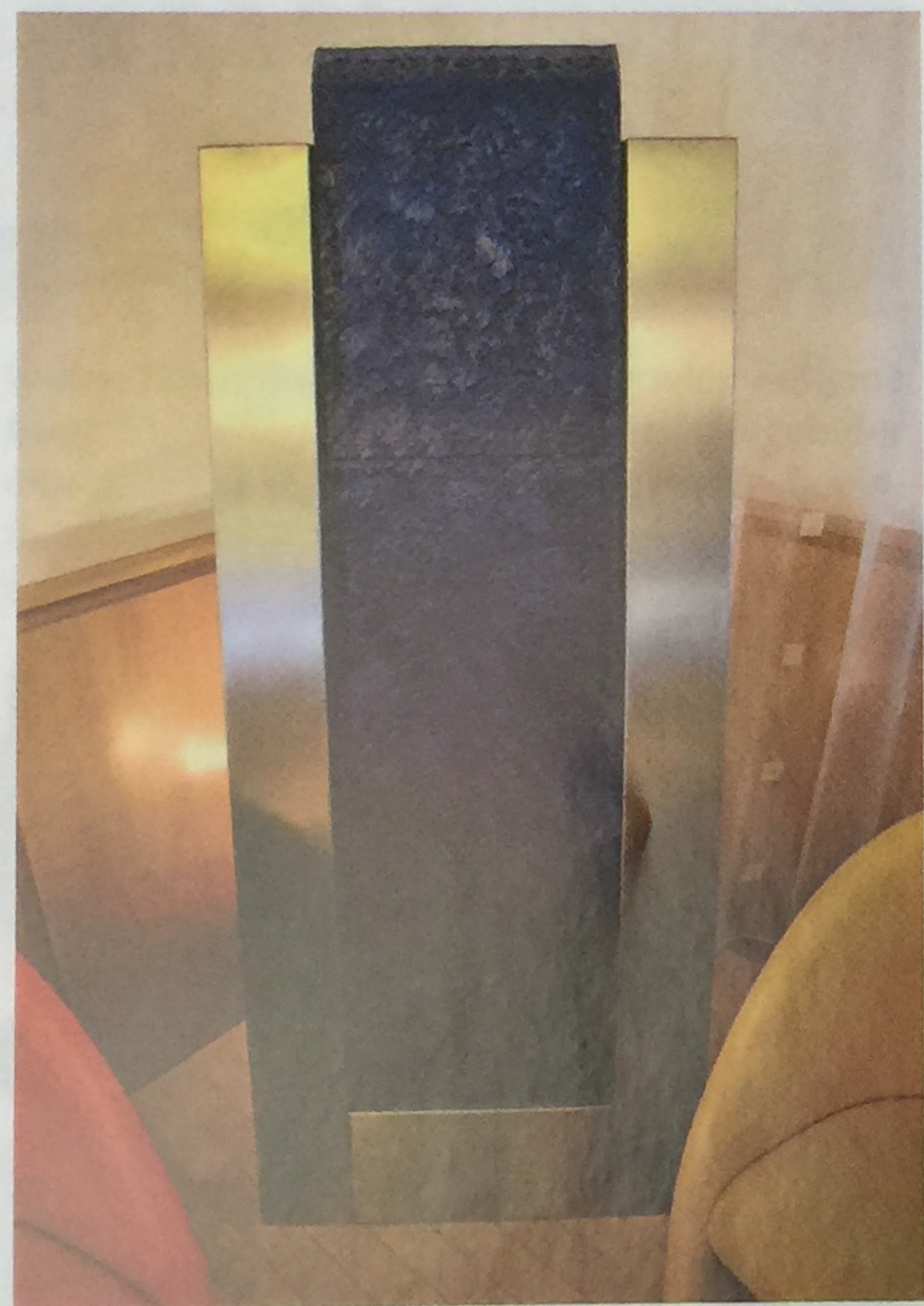
Die Wassersäule als Wohlfühlelement dient gleichzeitig der Luftreinigung und der Klimatisierung der Wartezone.
